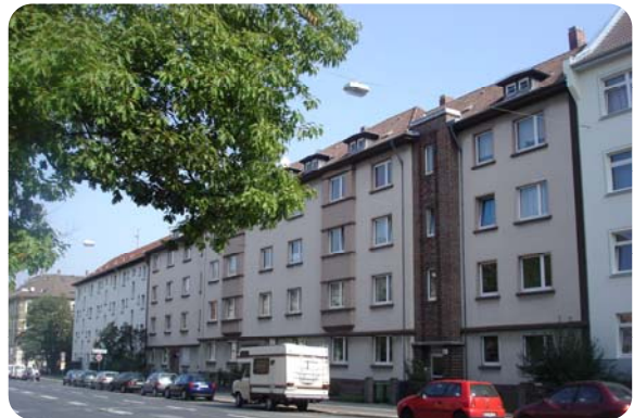
Altstadtring 37- 39 vor der Sanierung
