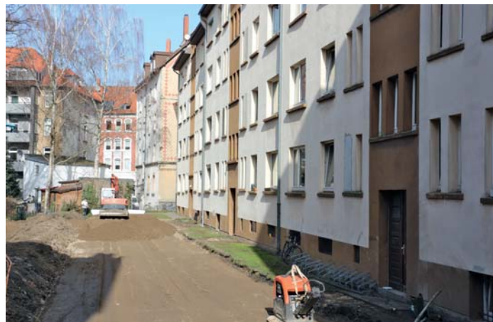
An der rückwärtigen Häuserseite wurde eine Baustellenzufahrt erstellt.
