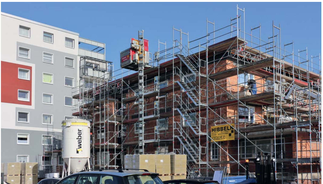
Blick auf die eingerüstete Fassade
