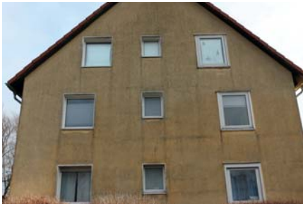
Zustand der Fassade vor der Reinigung
