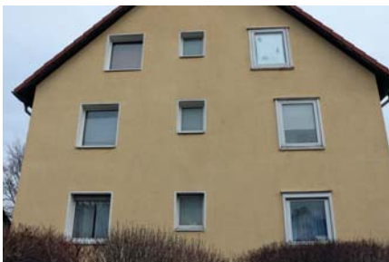
Die Fassade nach der Reinigung
