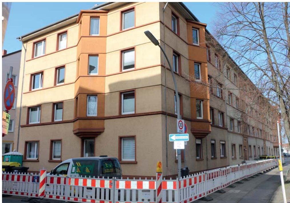
Die diesjährigen Sanierungsobjekte aus der Perspektive des Altstadtrings
