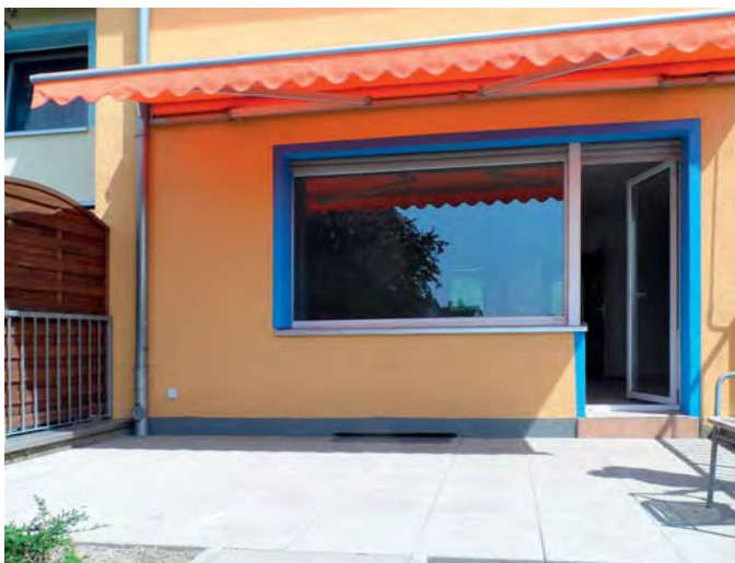
Neue Platten, neues Geländer: Auch die Terrasse wurde saniert.
