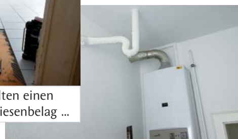
... und die Altinstallation hatte ausgedient und verschwand für immer
