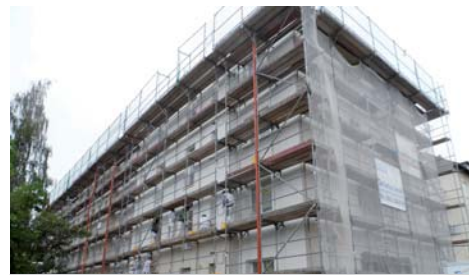
... im Juni fanden die Putzarbeiten an den rückwärtigen Fassaden statt
