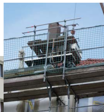
... die Schornsteine wurden abgetragen – dazu mussten sie auch eingerüstet werden
