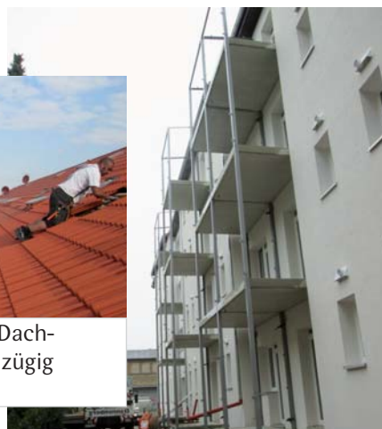
Anfang Juli begann die Montage der Vorstellbalkone auf den Hausrückseiten
