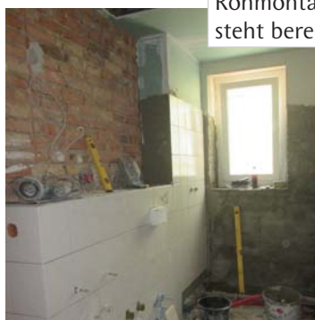
... im nächsten Schritt ist die Vorwand schon mit Rigipsplatten verkleidet und gefliest ...
