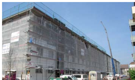
Die Dach- und Fassadenarbeiten sind bei herrlichem Wetter in vollem Gange ...
