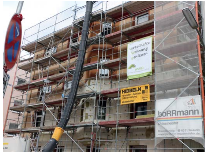
Giebelfassade Stolzestraße 14 - Bautenstand am 10. Mai
