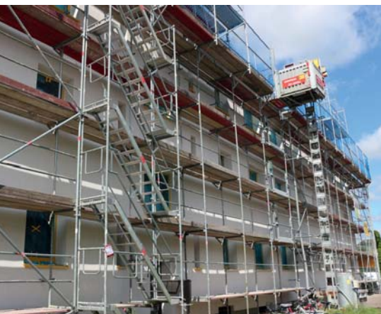
Blick auf die eingerüstete Hauseingangsfassade
