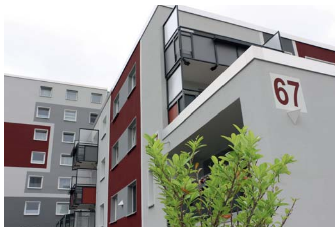
Blick auf die sanierten Hausfassaden
